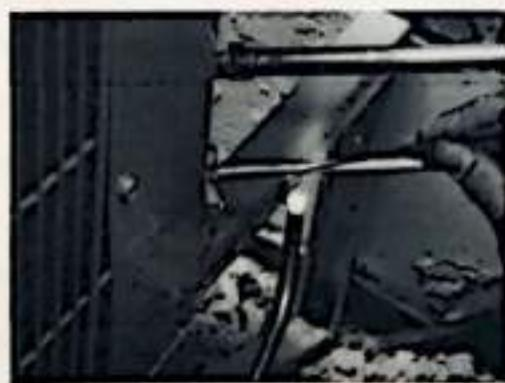
Nota: Proceso de unión de dos o más piezas de cobre o aleaciones de cobre mediante la aplicación de calor. Tomada de (Acrlatinoamerica.com., 2024)
