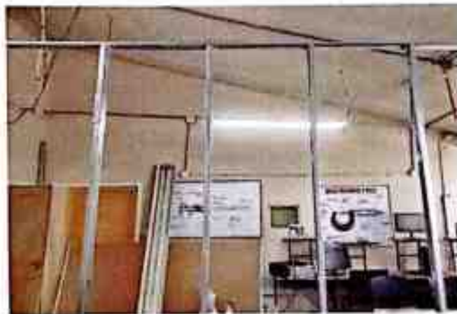
Figura 4. Delimitación y fijación de la de los studs
