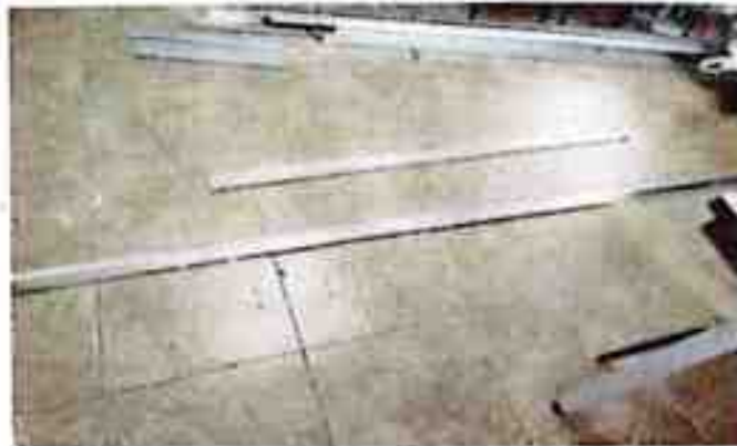
Figura 3. Anclaje de los tracks al suelo y paredes
