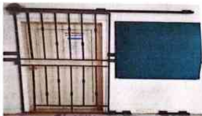
Figura 10. Puerta corrediza con sistema de riel.
