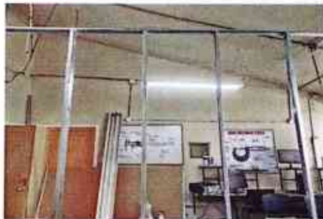
Figura 4. Delimitación y fijación de la de los studs
