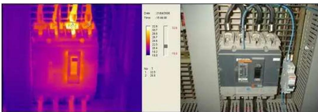
Figura 2: Incremento de resistividad debido a que los conectores no ajustan bien.
