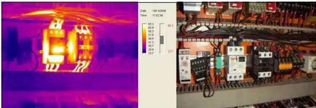
Figura 3: Imagen termográfica de dispositivos de protección sobrecargados.
