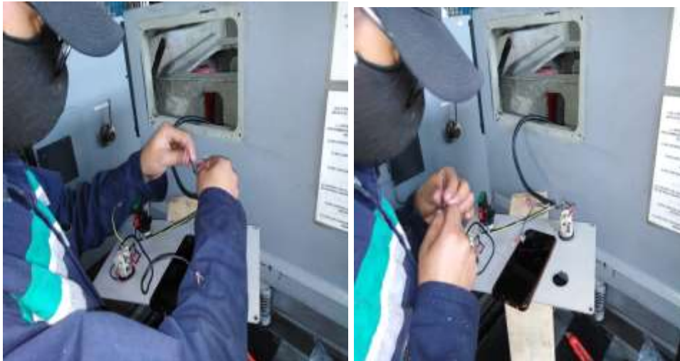
Imagen 5: Montaje de interruptor.
