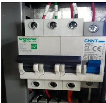
Figura 6 - Interruptor Termomagnético
