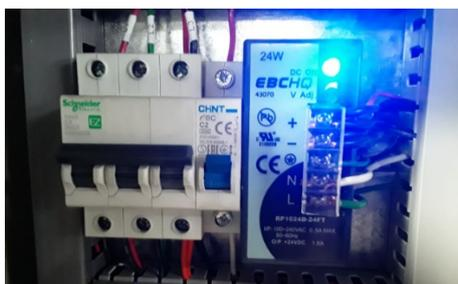
Figura 7. Interruptor termomagnético.
